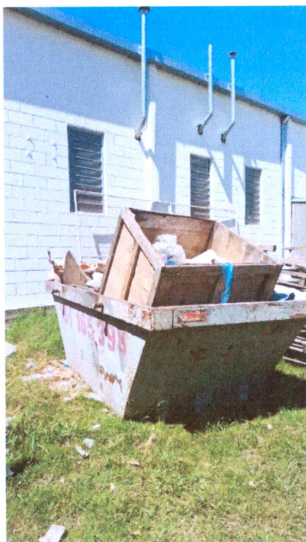
Imagen fotográfica 6. Contenedor con material reciclable.
