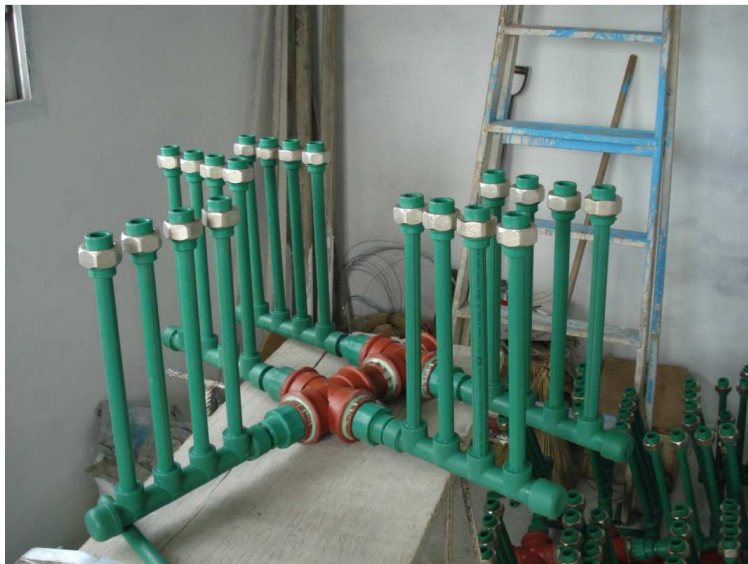
Armado del Árbol de distribución, para luego unir a tronco del árbol en cañería de \phi 2".
